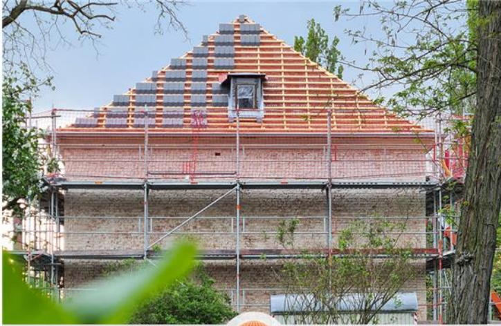
Dacheindeckung mit Biberschwanzziegeln
